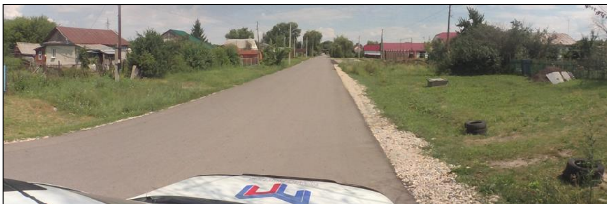
Рисунок 1.3.7 – Состояние дорожного покрытия ул. Первомайская, р.п. Екатериновка на момент обследования
