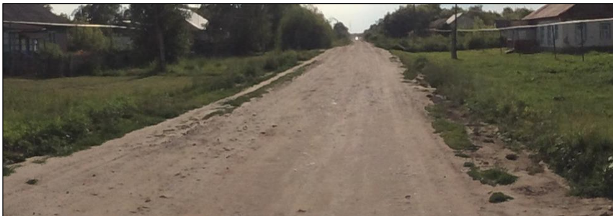
Рисунок 1.3.24 – Состояние дорожного покрытия ул. Майская, д. Малая Екатериновка на момент обследования
